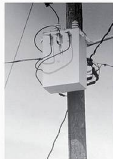
Figura 20.16 Transformador de distribuição com metal amorfo montado em um poste. (Cortesia da Metglas.)
